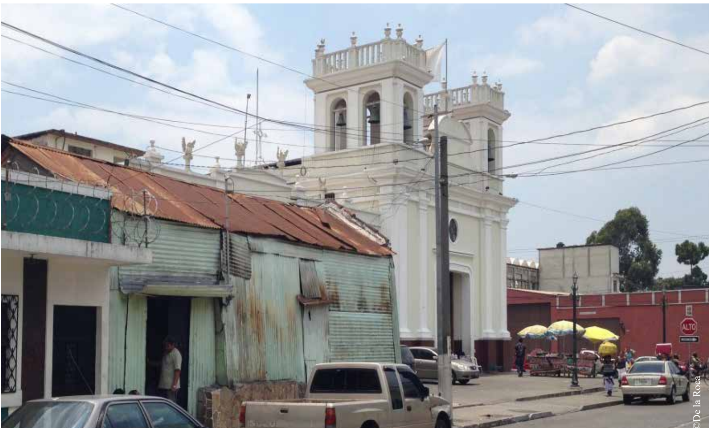
Figura 3. Este templo le da nombre al Barrio, ubicado en la 13 avenida 1-20 zona 1, En la vecindad se ve la vivienda no restaurada y sin intervención. Su fachada colapsó debido al terremoto del 76 le construyeron una provisional con lámina, la cual no ha sido restaurada. Fotografía captada el 11-marzo-2016, autor Leonel Alberto De la Roca Coronado.
